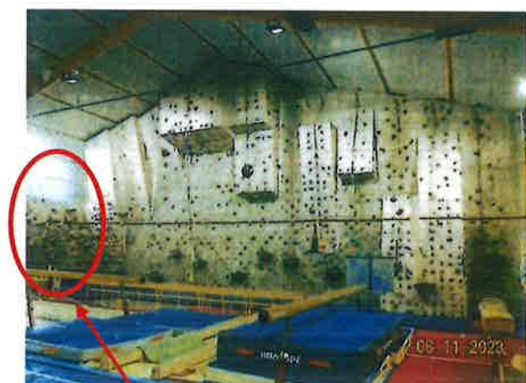
Murs d'escalade façade sud
