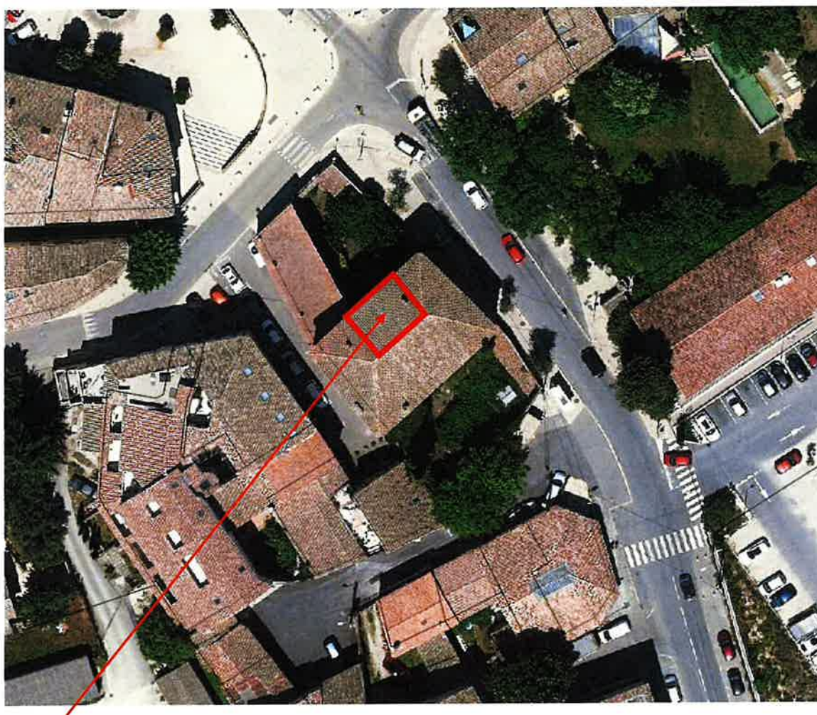
Partie de toiture effondrée
